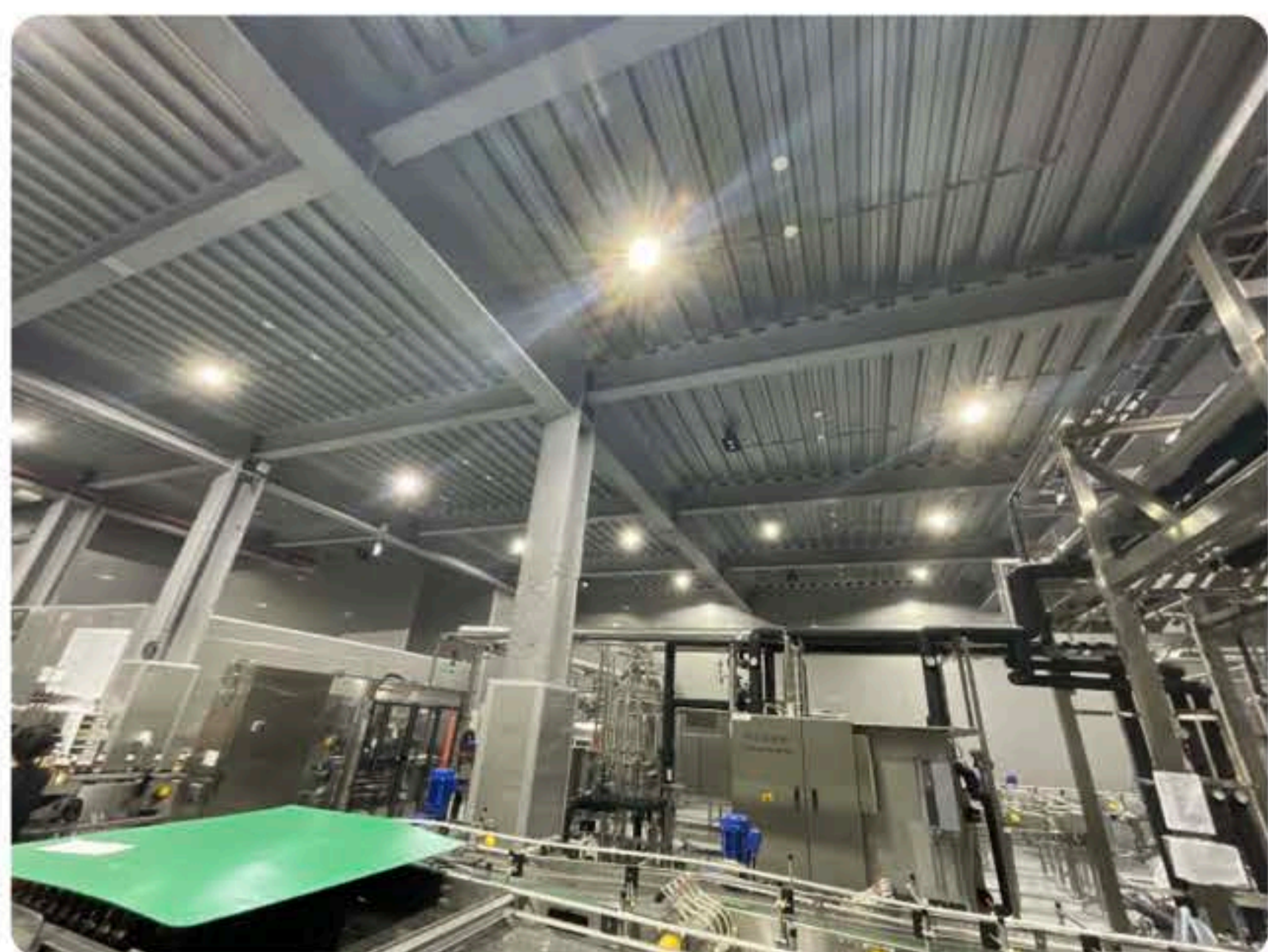
安裝後照片 (產線1)
